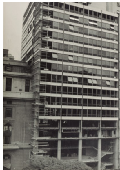
VISTA. Obra en construcción desde L. N. Alem
